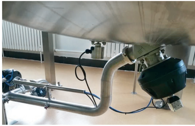
Abbildung 1: Die kompakte Kombination von Druckmittler und Messgerät findet ohne Probleme unter den Tanks von Red-Bull Platz.
